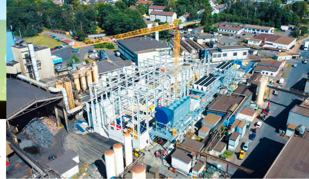
Luftaufnahme der Baustelle der neuen Gießerei
