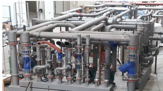
Fertigung von Rohrleitungssystemen
